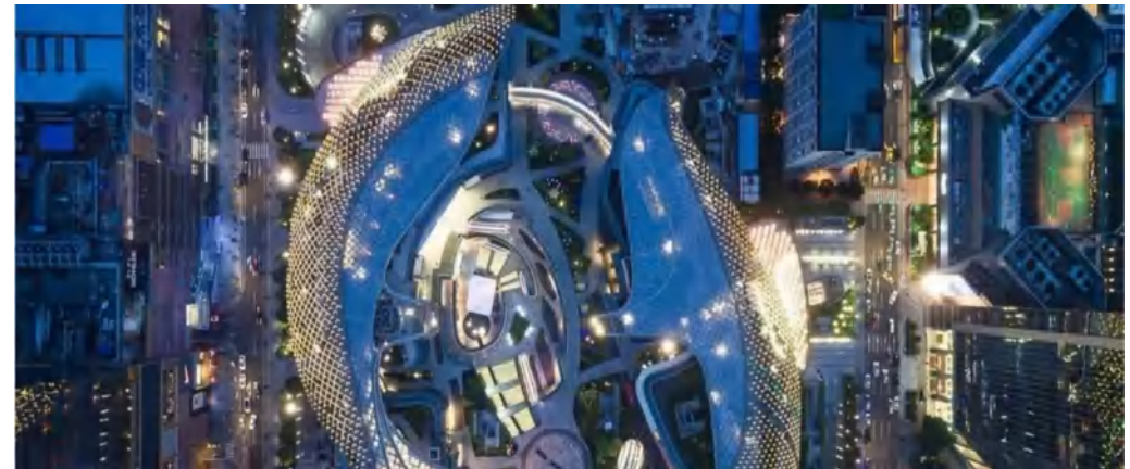
Guangzhou Parc Central
